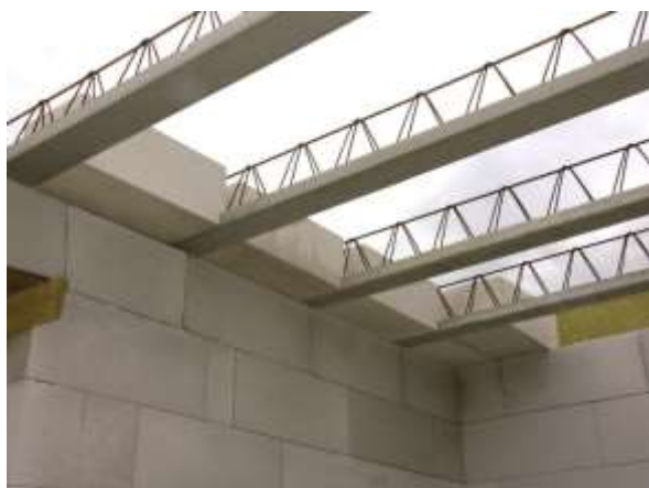
Ytong strop kao međukatna konstrukcija
