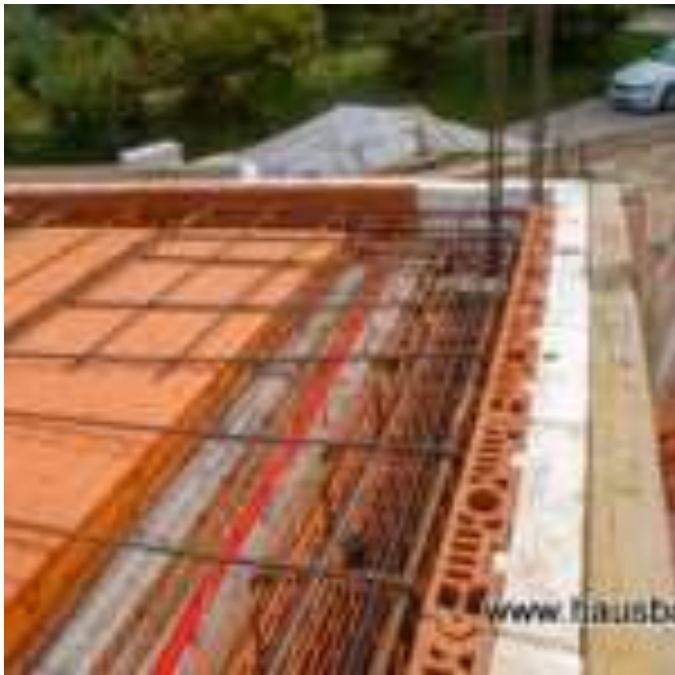
UGAO ZGRADE U IZGRADNJI SA POROTHERM SISTEMOM
