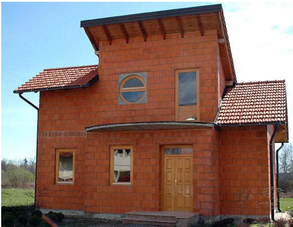
OBITELJSKA KUĆA IZGRAĐENA S ELEMEMENTIMA POROTHERM SISTEMA: BLOK ZA ZIDOVE I STROPNI SUSTAVI.
