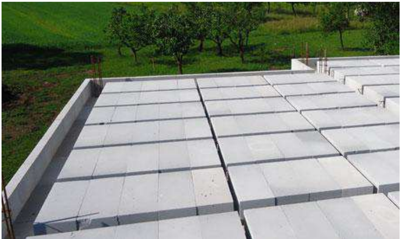
IZGLED BIJELOG STROPA SA SVIM ELEMENTIMA: STROPNI BLOK, GREDICA, LEŽAJNICE, HORIZONTALNI ELEMENTI ZA SERKLAŽE, ARMATURA VERTIKALNIH SERKLAŽA.
