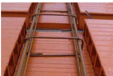
POGLED NA GREDU S PODLOŽKOM I REBRASTU ARMATURU
