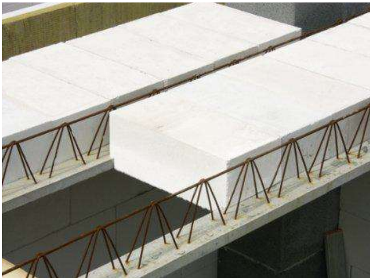
Postavljanje gređice i stropnog bloka.
