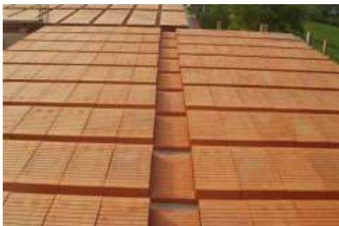
POGLED NA STROP
