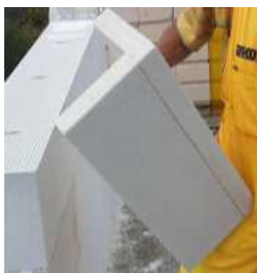
„L“ ELEMENT – ZA IZRADU HORIZONTALNOG SERKLAŽA (UKRUTE – VEZE)
