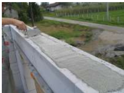
„L“ ELEMENT – ZA IZRADU HORIZONTALNOG SERKLAŽA (UKRUTE – VEZE)
