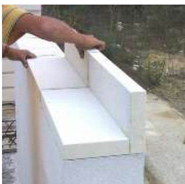
„L“ ELEMENT – ZA IZRADU HORIZONTALNOG SERKLAŽA (UKRUTE – VEZE)
